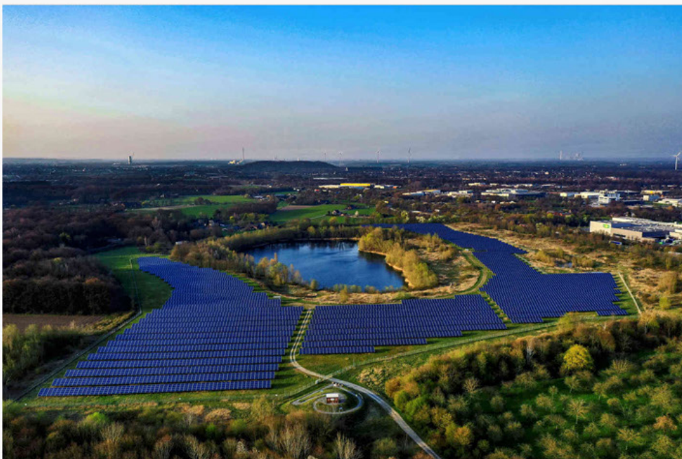
Einen Solarpark betreibt der Energieversorger ENNI im Mühlenfeld in Neukirchen-Vluyn. Auch damit soll die Energiewende vorangebracht werden. Foto: Norbert Prümen
